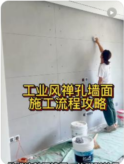
工业风禅孔清水砼墙面施工流程攻略 Y艺界微水泥艺术漆工厂 21
